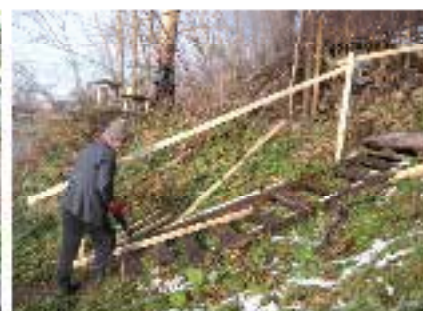
Ремонт ручной лестницы на Университетском сквере. Ноябрь 2015 г.
